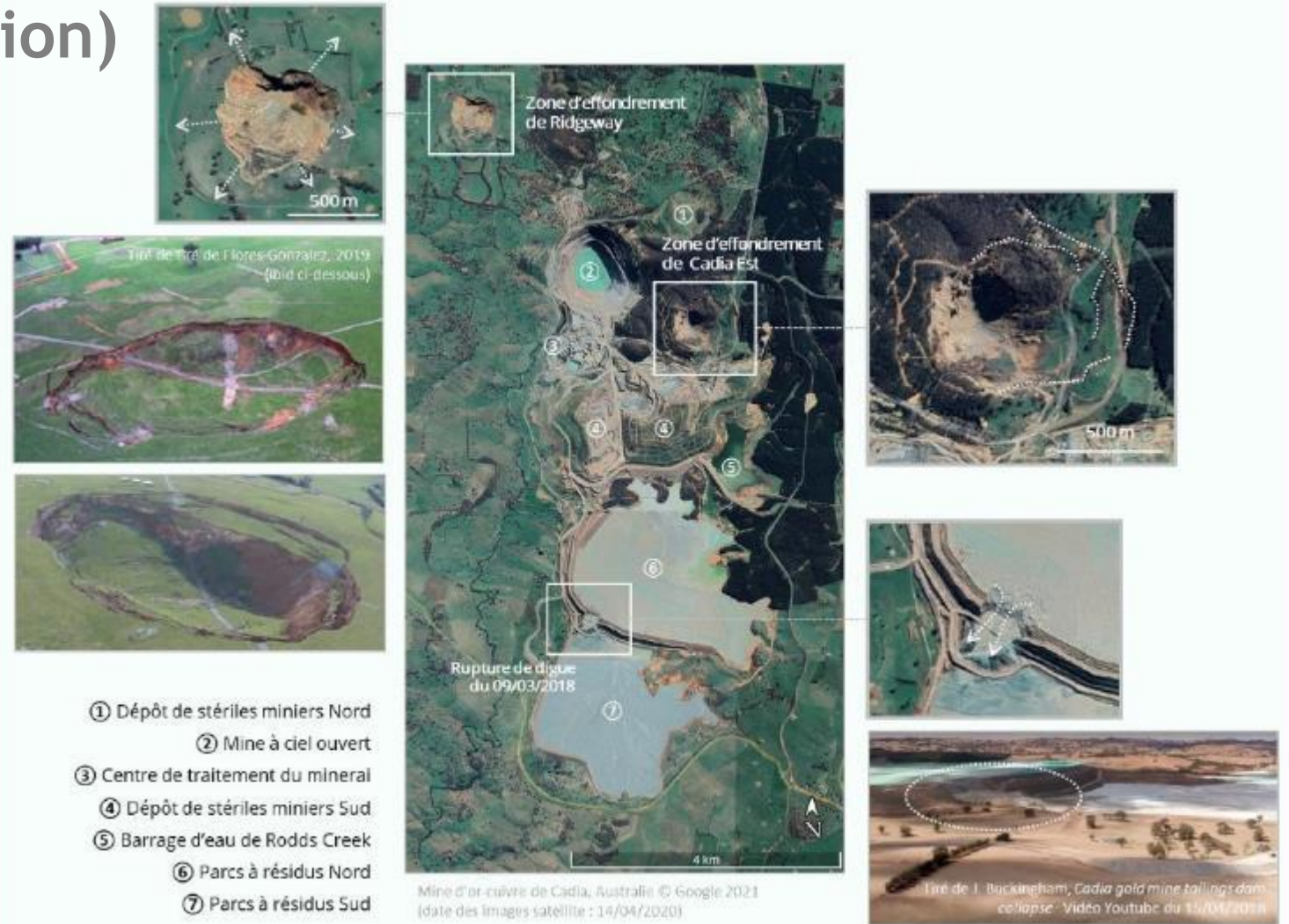
Figure 26 : Situation de la mine d'or cuivre de Cadia, Australie, zones d'effondrement et rupture de digue du 09/03/2018 (Création : SystExt · Octobre 2021)
