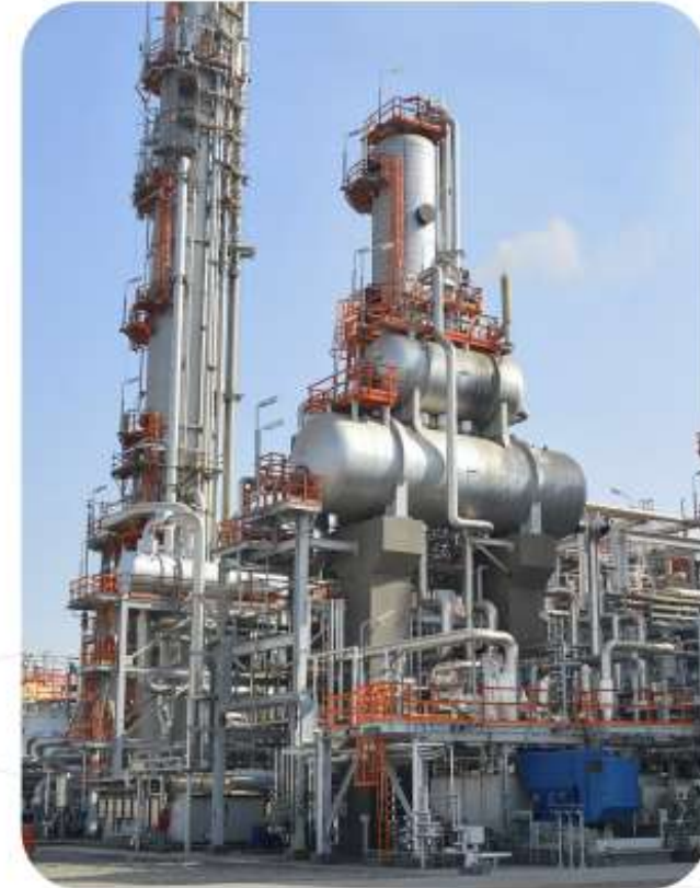
Exemple : Garabogaz Usine d'urée au Turkménistan
